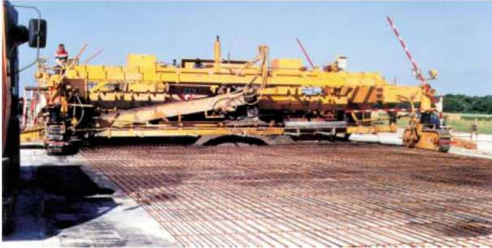
Figure 22. Chaussée en dalle en béton armée.
